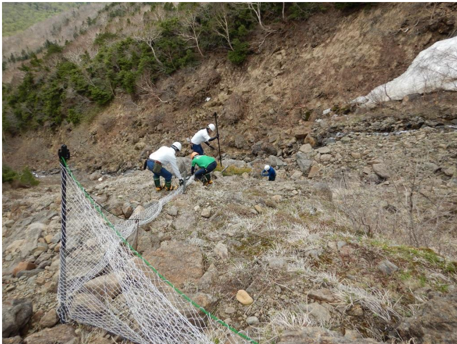
消雪直後の植生保護柵のネット設置作業(5/20)
