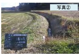
用排水路整備前(馬場工区)
