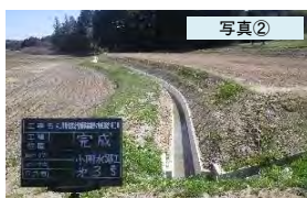
用排水路整備後(馬場工区)
