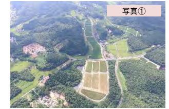
ほ場整備後(外山工区)
