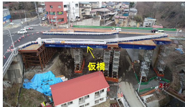
仮橋供用開始前（H31.3月）に撮影
