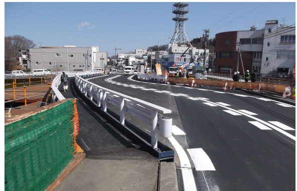
仮橋供用開始日（H31.4.16）に撮影
