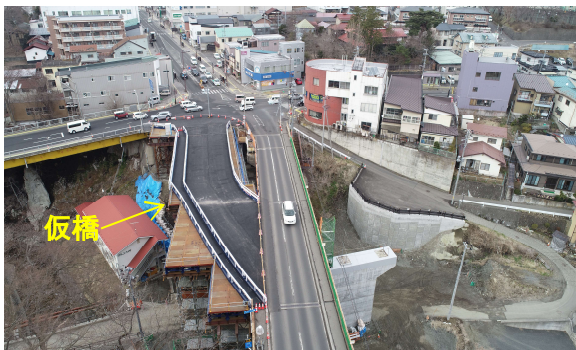
仮橋供用開始前（H31.3月）に撮影
