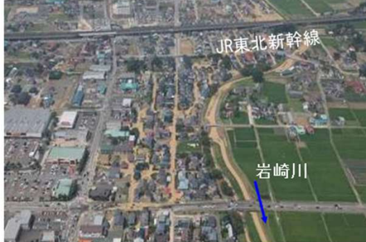
③芋沢川浸水状況
