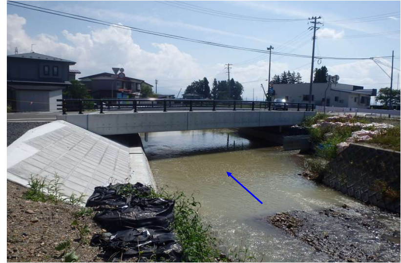
【写真① 岩崎川橋（H28.6供用）】
