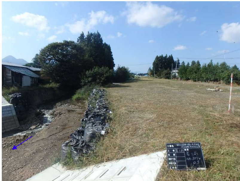
【写真② 六助橋～矢次ノ外橋（着手前）】
