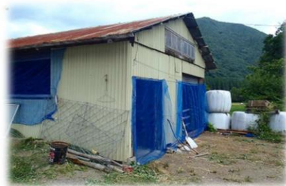
図 10-6 防虫ネット設置
