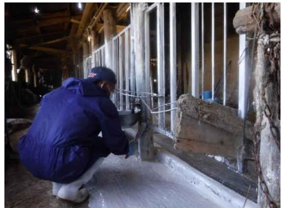
図 10-12 ブラシを用いた石灰乳の塗布
