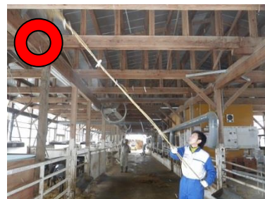
図 3-4 天井も梁も掃除
