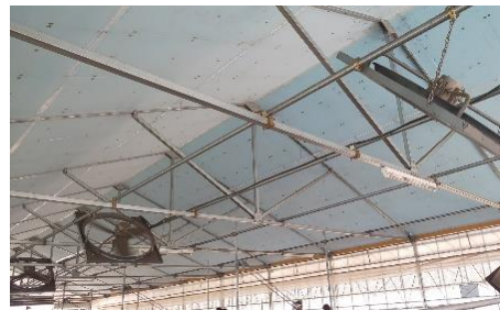
図 6-5 断熱材の利用例
