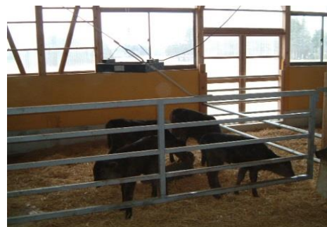
図 6-13 吊下げ式電気ヒーター
