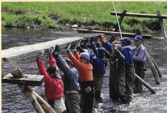
下有住名物「松日橋」の修復
