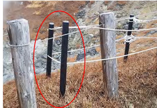
樹脂杭（ロープ2段）
