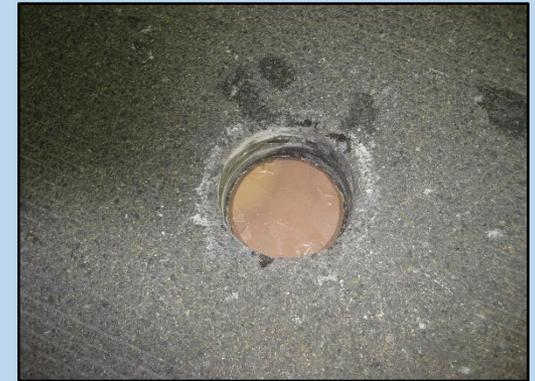
④ 埋戻し前の保護板設置
