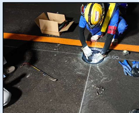
⑤ 灯器設置状況
