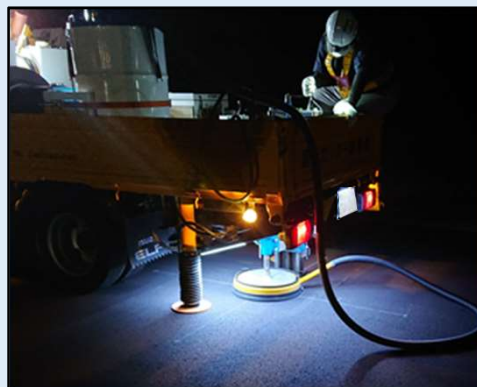
② コアカッターによる削孔(2)
