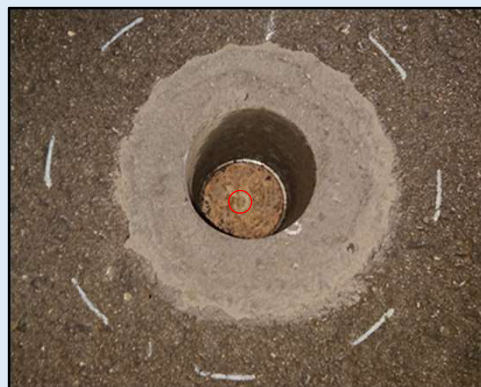
② 中心を確認し削孔位置を作図 （保護板の○部分が中心位置）
