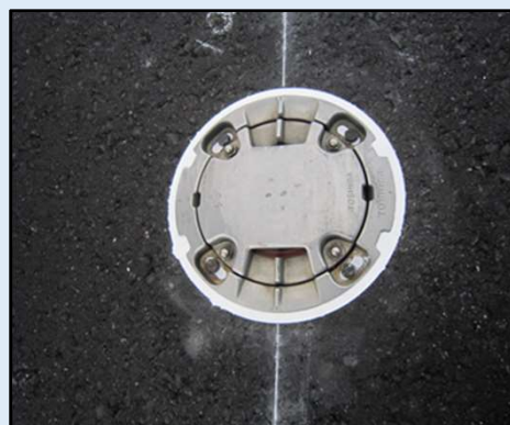
⑤ 灯器設置完了
