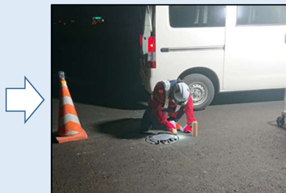
④ 灯火設置後の樹脂注入 (孔と灯器の隙間に注入)
