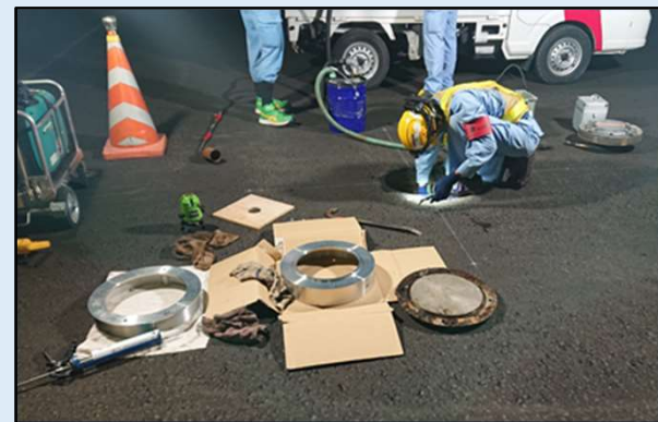
③ 削孔部の清掃状況及び使用材料
