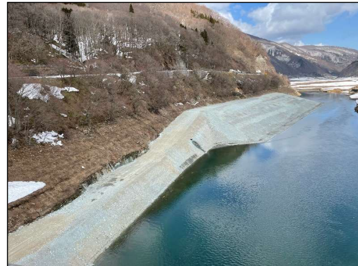
完了後 令和4年4月5日撮影
