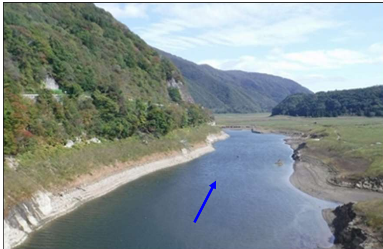
施工前 令和3年10月19日撮影
