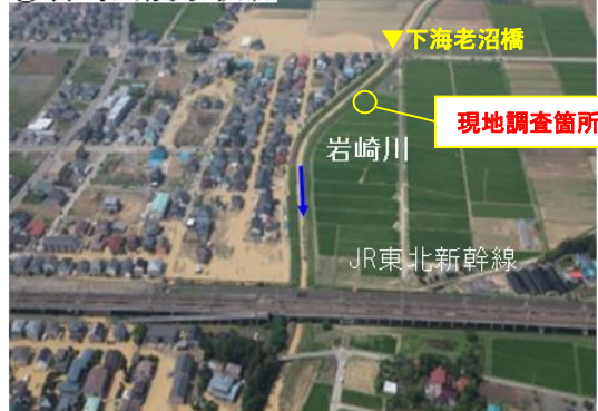
②岩崎川浸水状況
