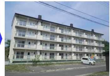
改修事業（バリアフリー化・省エネ化等性能の向上）
