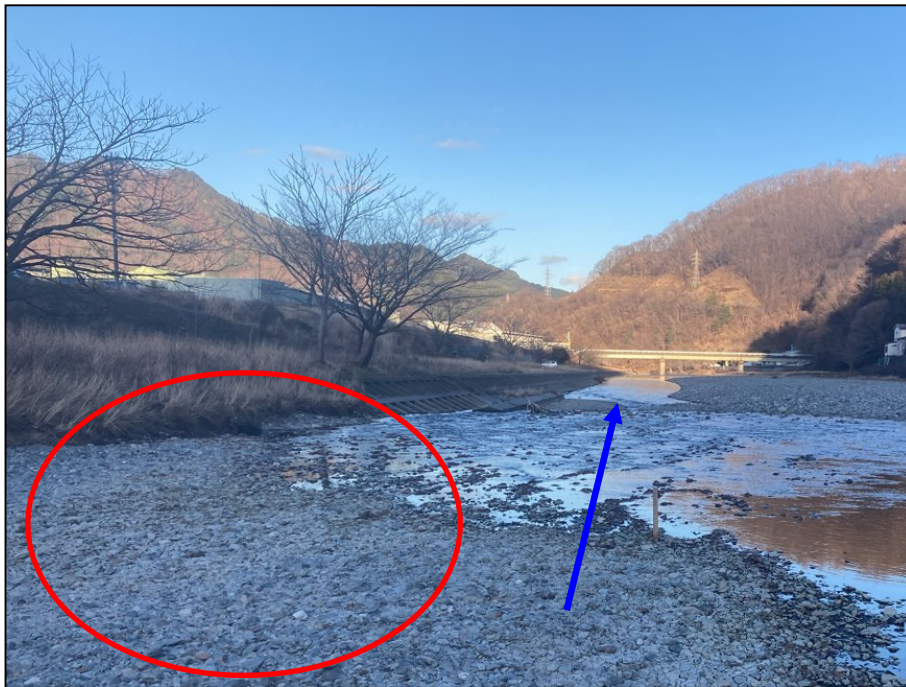
上中島地区 施工前
