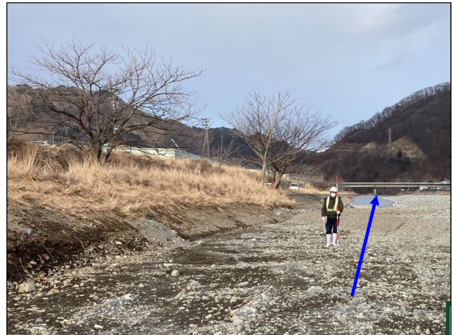
上中島 施工後
