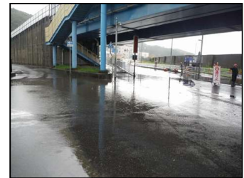
冠水状況(R3.9.15)
