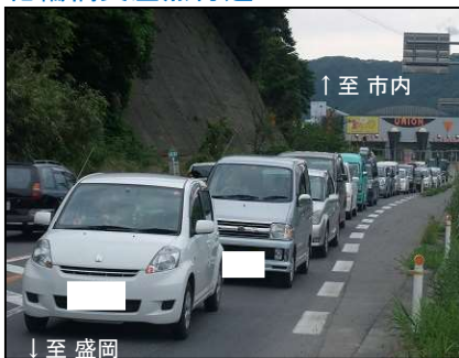
整備前 (交通渋滞発生状況 : H23.7月撮影)
