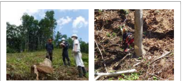
【沿岸広域振興局岩泉林務出張所】広葉樹の伐倒実演し、各種手順が適正に遵守されているかを点検した。
