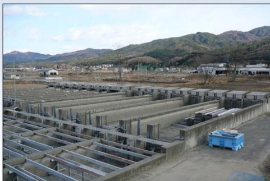
サケふ化場の復旧・整備 (津軽石川ふ化場)
