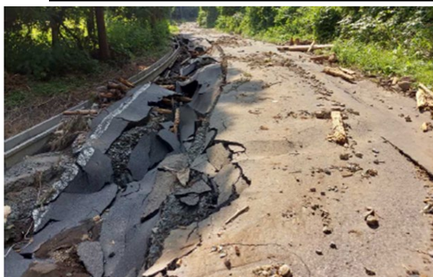
町道小繫平糠線小繫地内（一戸町）
