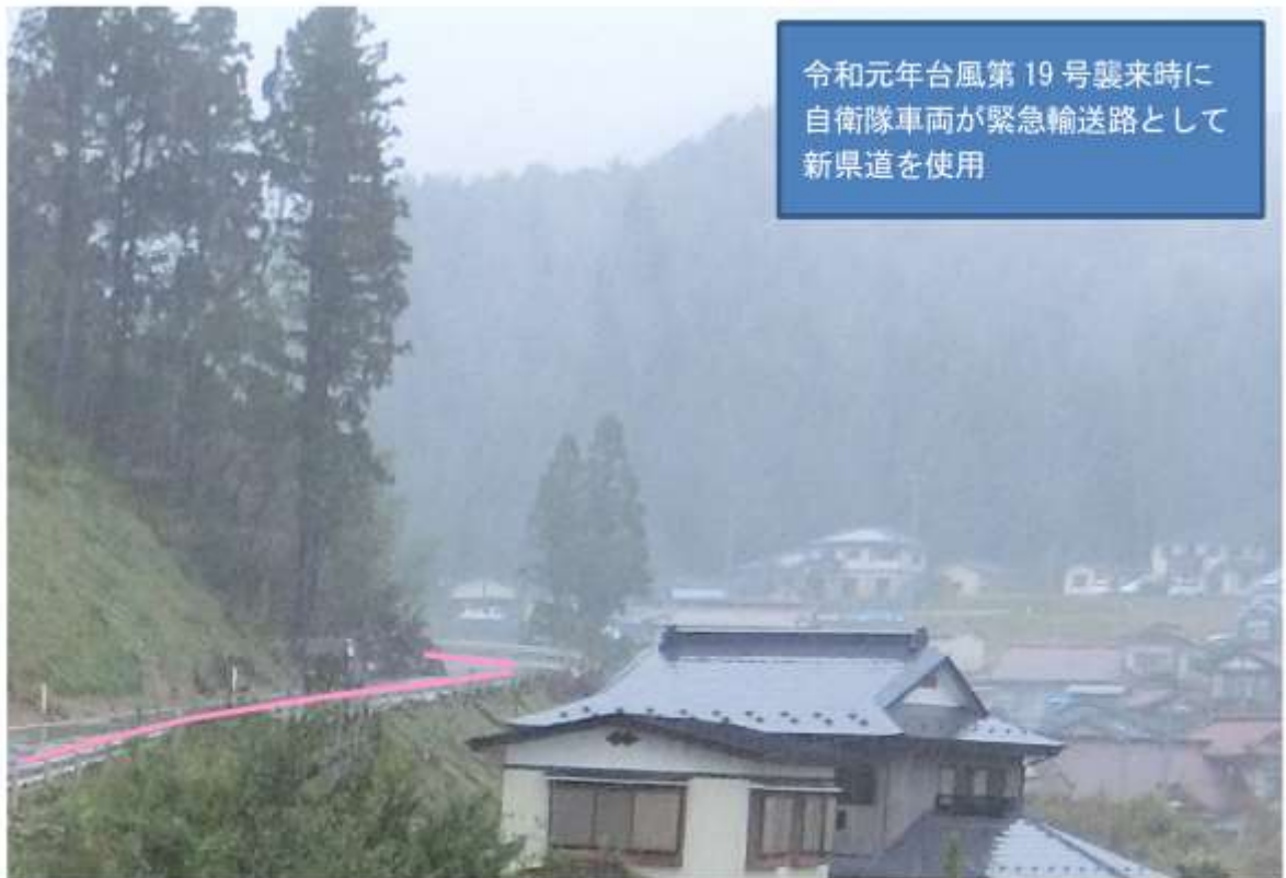
【整備後の新県道の状況】（令和元年 10 月撮影）
