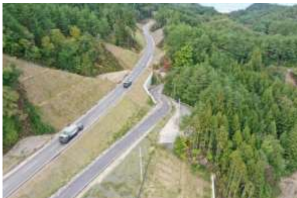
【令和元年台風19号時に、自衛隊が緊急輸送道路として使用 令和元年10月撮影】
