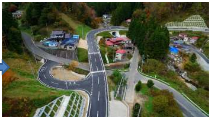
【整備後の新県道の状況】
