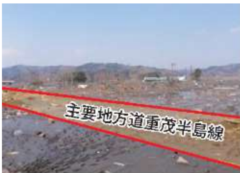
【整備前の県道の被災状況】
