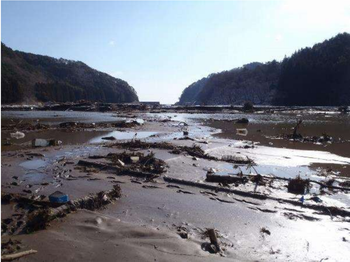
【整備前の被災状況（摂待工区）】
