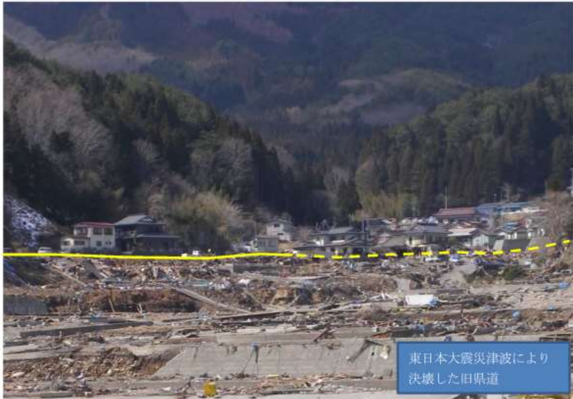
【整備前の旧県道の被災状況】（平成 23 年 3 月撮影）
