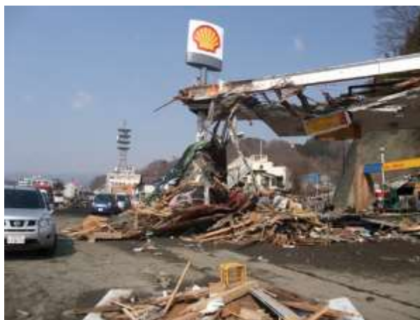
【整備前の県道の被災状況】
