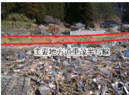
【整備前の県道の被災状況】
