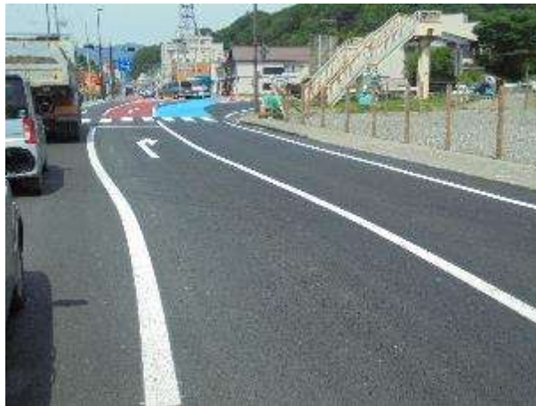
【整備後の新県道の状況】
