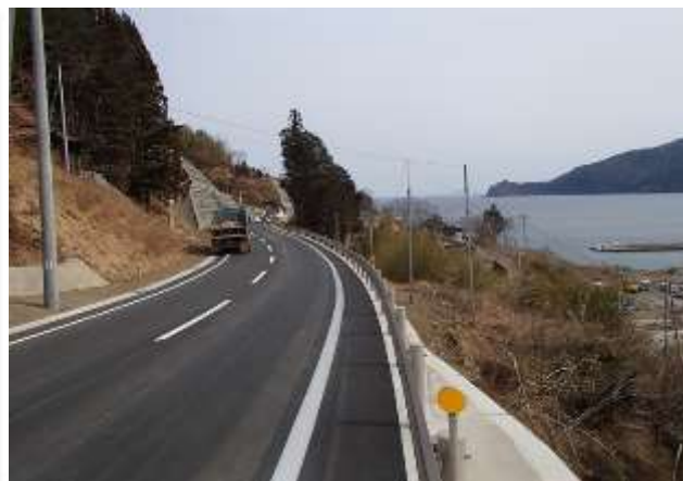
【整備後の新県道の状況】
