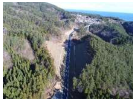
【整備後の新県道の状況】
