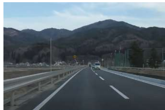
【整備後の新県道の状況】
