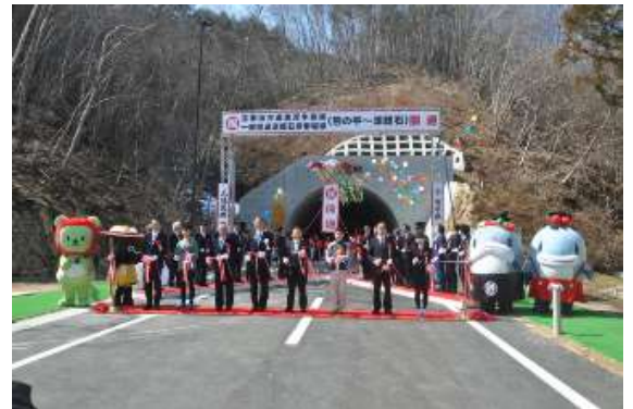
【整備後の新県道の状況】
