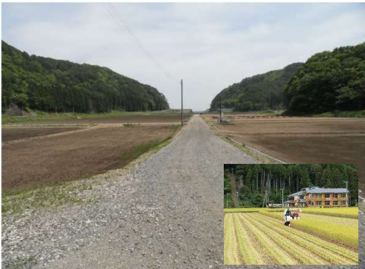
【整備後の状況（摂待工区）】
