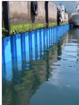
(鋼製防波堤の対策後)
