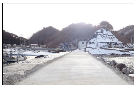
(護岸舗装の対策後)
