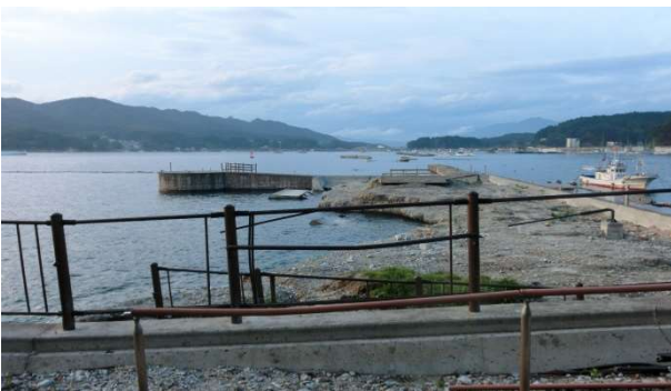
<被災直後の状況>
