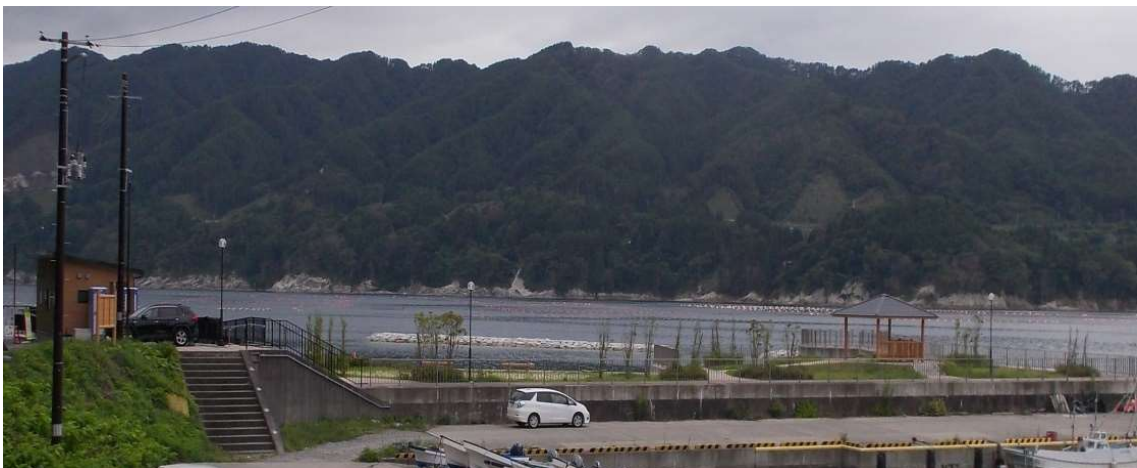
<整備後の状況（全景）>
