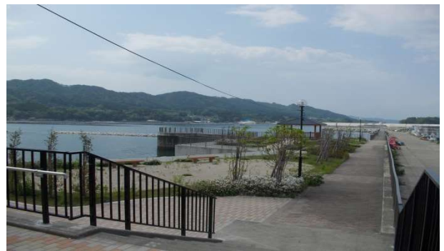
<整備後の状況>
