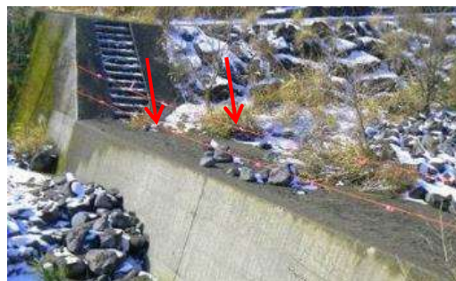
土砂移動検知センサー
