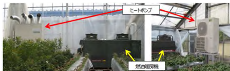
ヒートポンプと燃油暖房機のハイブリッド運転による 燃油使用量の削減
