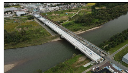
地域連携道路整備事業（徳田橋）
