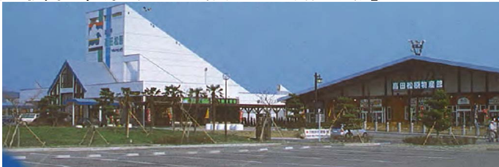
写真:被災前の道の駅高田松原(写真:道の駅高田松原パンフレット)
