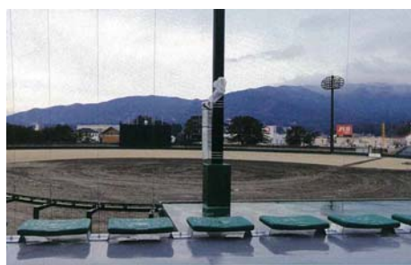
高田松原第一野球場（改修・竣工前）
