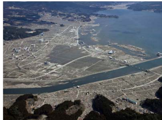
被災後写真：2011年（平成23年）3月28日撮影
