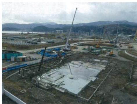
高田松原物産館跡
