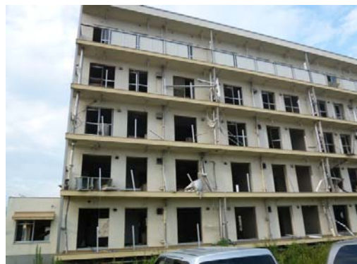
下宿定住促進住宅一号棟
