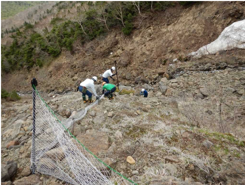
消雪直後の植生保護柵のネット設置作業(5/19)
