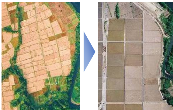
【ほ場整備により大区画化された水田】
