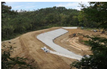
【ため池の対策工事状況】
