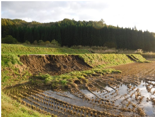
【田の法面崩落】
