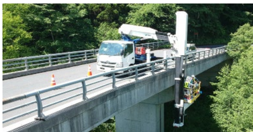
【農道橋の劣化調査】
