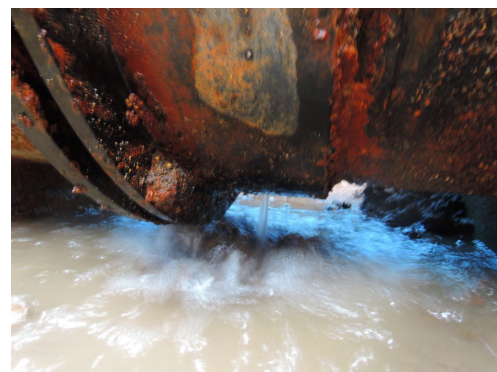
【パイプラインの破損による突発事故】
