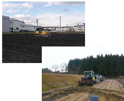
【区画拡大、暗渠排水などのきめ細かな基盤整備】
