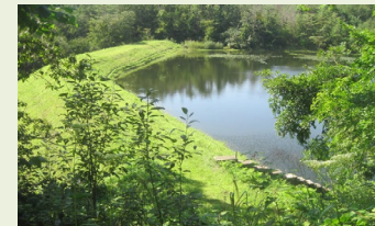
【対策が必要なため池】
