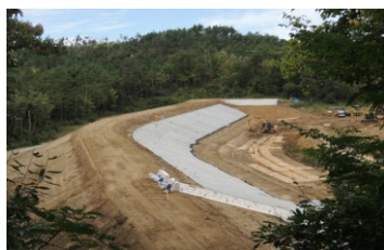
【ため池の対策工事状況】
