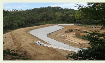
【ため池の対策工事状況】
