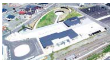
完成した「釜石祈りのパーク」、「いのちをつなぐ未来館」、「鶴の郷交流館」(平成31年3月供用開始)
