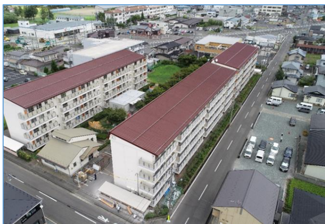
改修を終えた県営内匠田アパート
