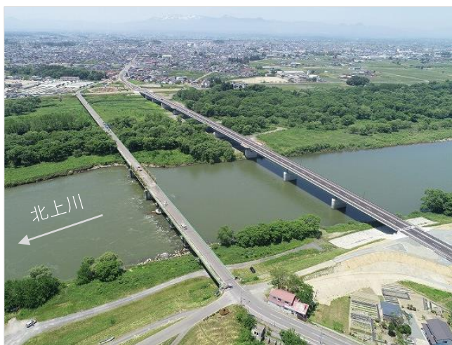
解体撤去前の旧小谷木橋（左）と新小谷木橋（右）
