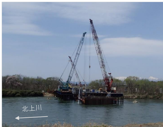
解体撤去中の旧小谷木橋
