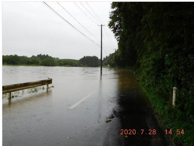
令和2年7月28日の豪雨による路面冠水
