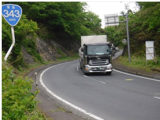
線形不良箇所
