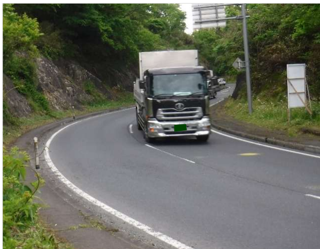
線形不良箇所
