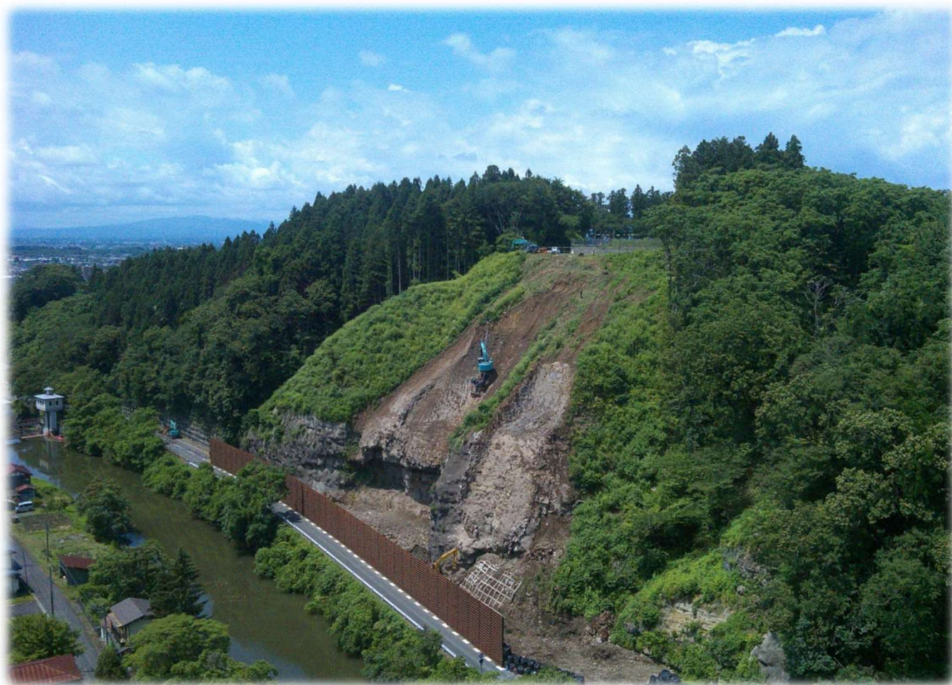
主要地方道水沢米里線 館山法面对策工事
