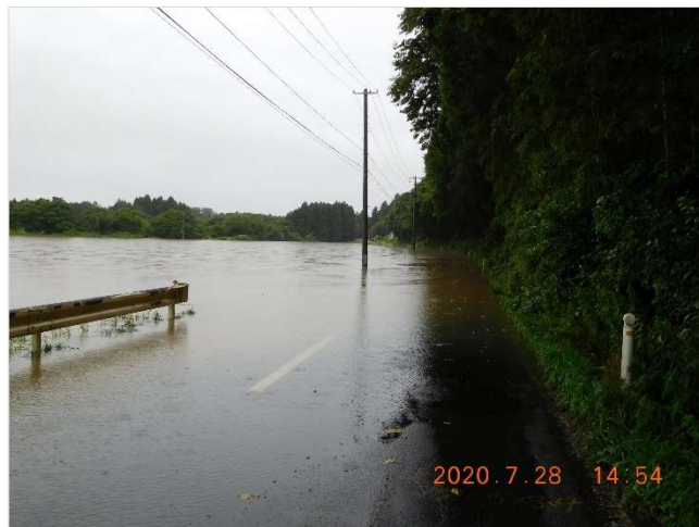
令和2年7月28日の豪雨による路面冠水
