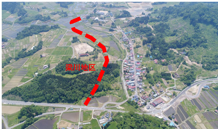
梁川地区全景
