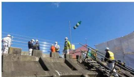
工事安全パトロールの状況
