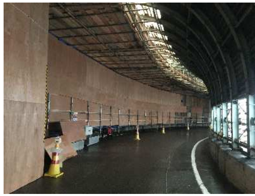
主要地方道久慈岩泉線大月峠スノーシェルター補修
