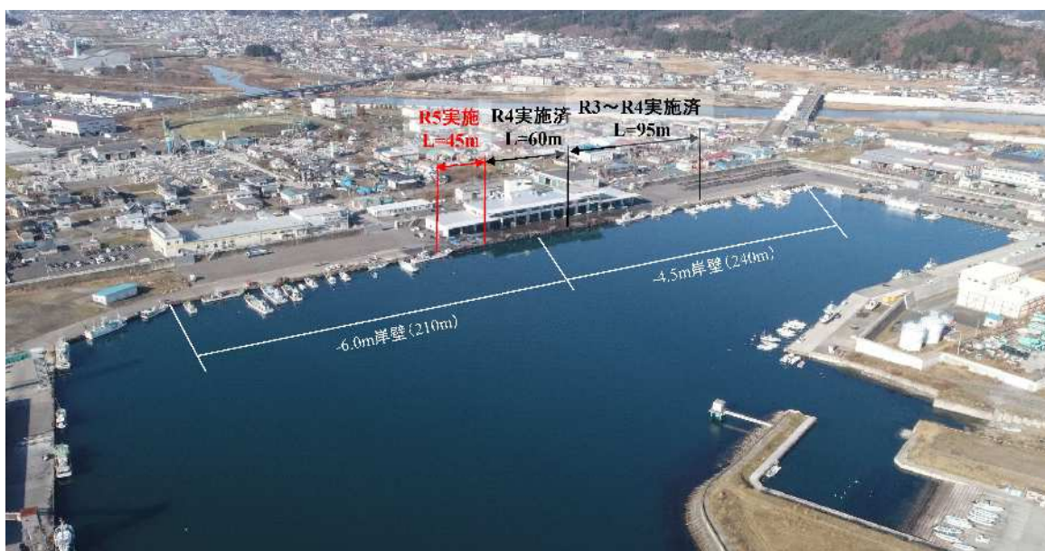
久慈港諏訪下地区岸壁等補修
