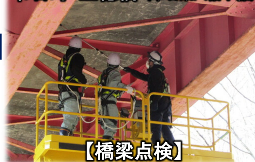
雫石町 正徳橋（雫石東八幡平線）
