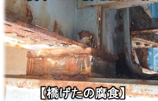
一関市 上の橋（国道284号）
