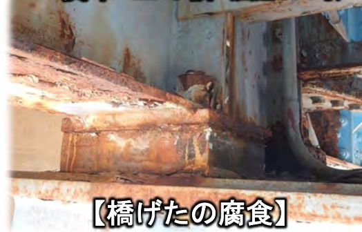
一関市 上の橋（国道284号）
