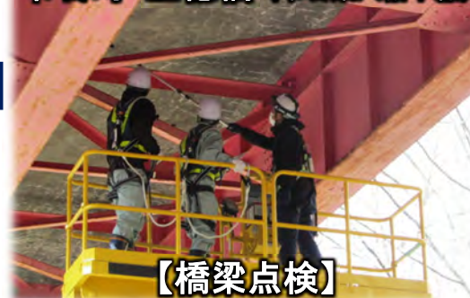
雫石町 正徳橋（雫石東八幡平線）
