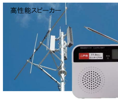
防災ラジオ、高性能スピーカー(二戸市)
