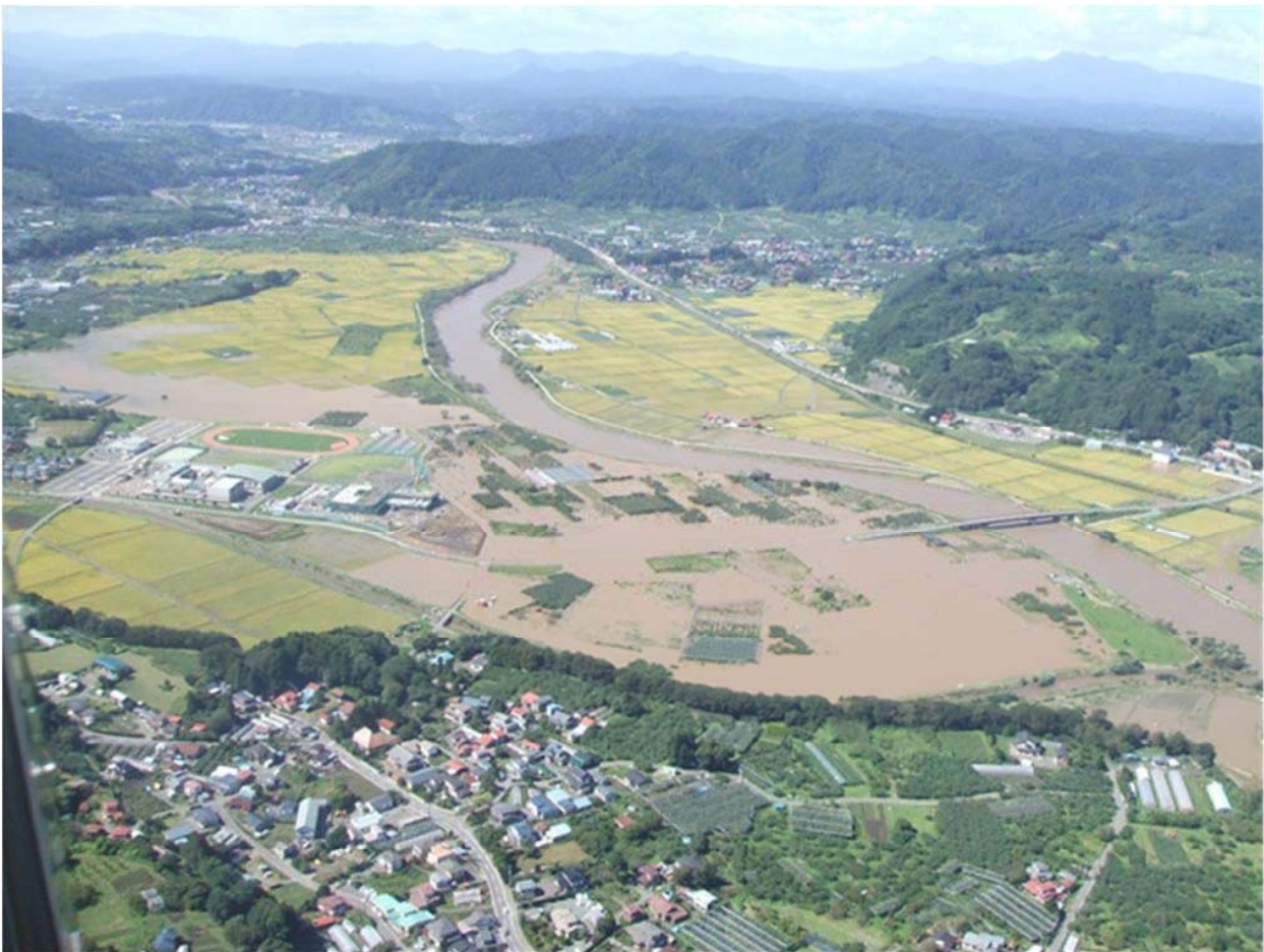
平成25年9月 台風18号による出水状況（南部町下名久井地区）
