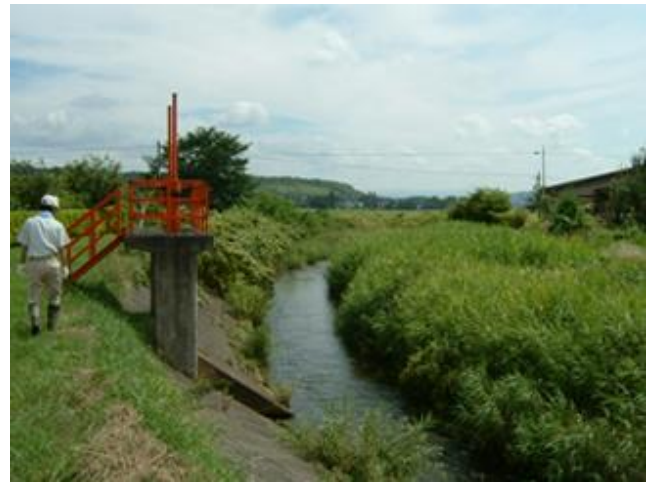
排水施設等の点検状況
