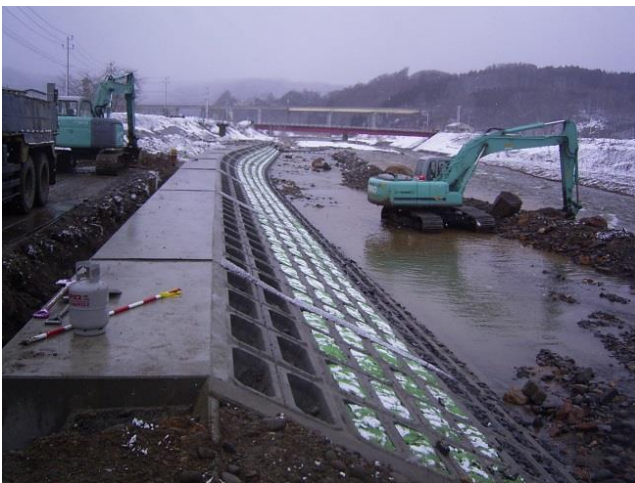
災害復旧工事の状況
