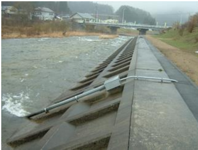
水位計設置状況
