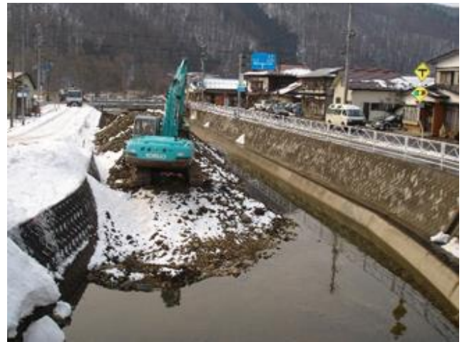
河道掘削状況
