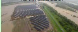
堤防の決壊による氾濫状況 (札内川:北海道帯広市)
