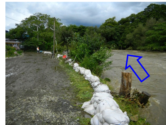
馬淵川岩根橋下流左岸（一戸町関屋地区）
