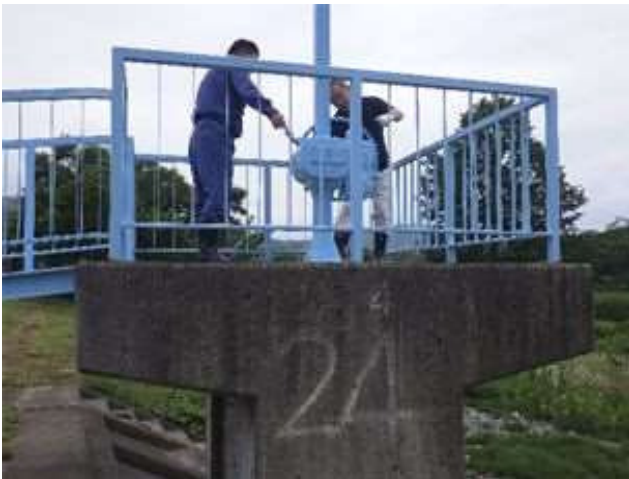
水門点検活動状況
