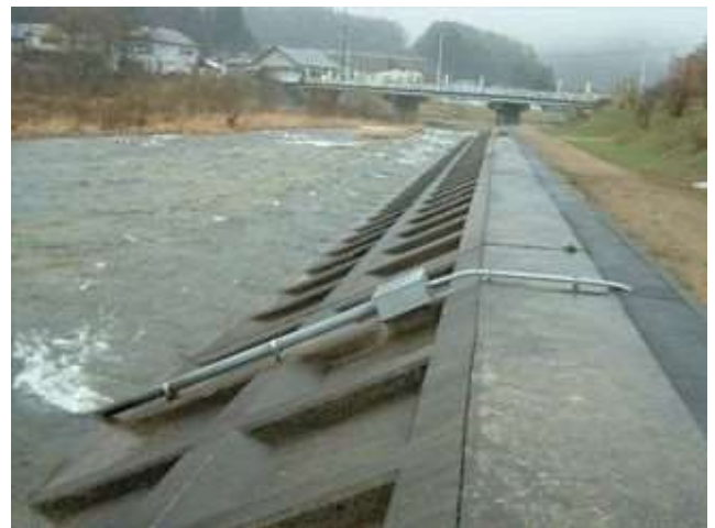
水位計設置状況
