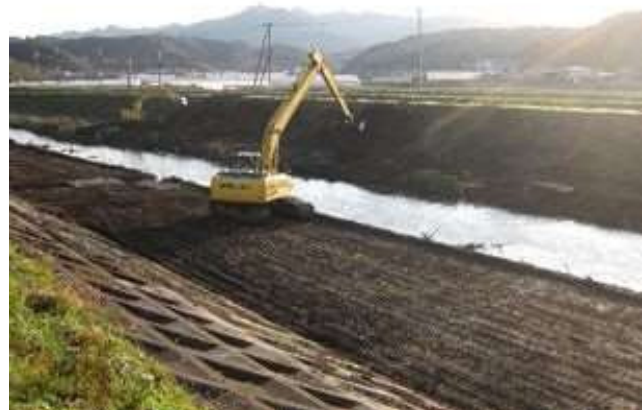
河道掘削の状況
