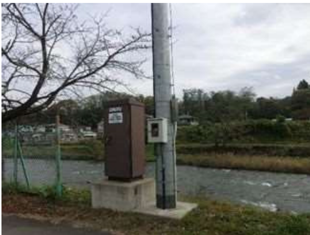
水位計設置状況
