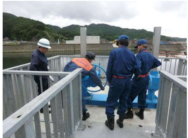
水門点検活動状況
