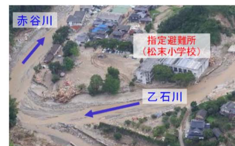
土砂・流木により被災した避難所
