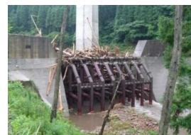
透過型砂防堰堤による流木捕捉事例
