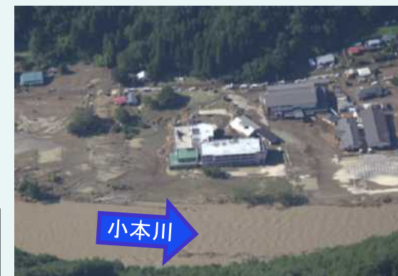
小本川の浸水被害の様子 (平成28年8月 台風10号)
