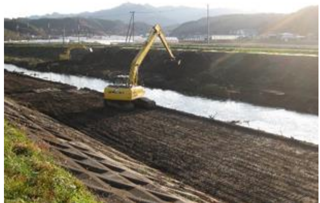
河道掘削の状況
