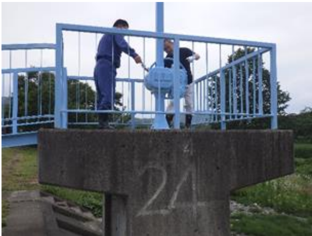
水門点検活動状況
