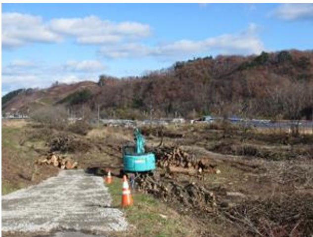
立ち木伐採の状況
