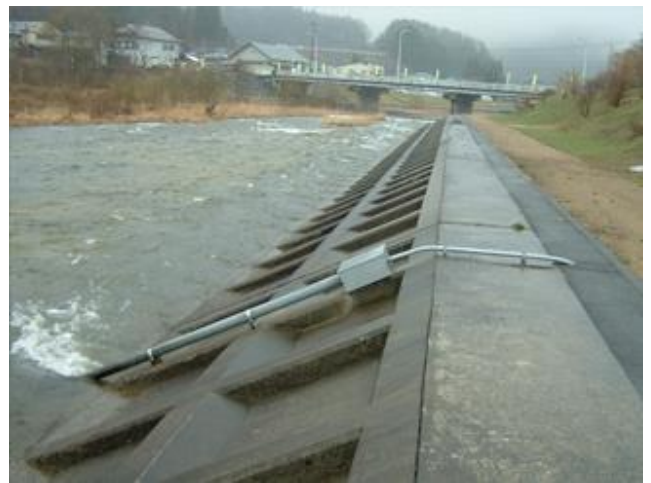
水位計設置状況
