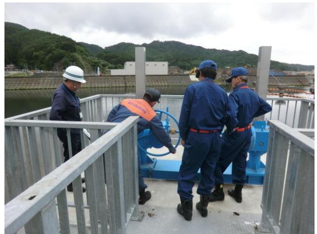
水門点検活動状況
