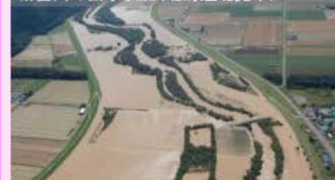
越水による堤防の法崩れ(常呂川)
