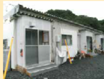
応急仮設住宅・みなし仮設住宅
