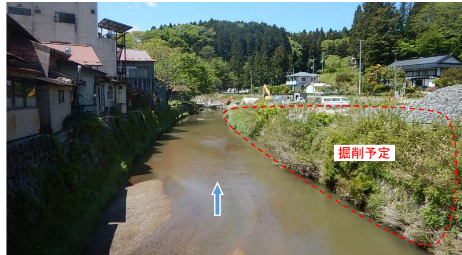
⑤【未着手】めおと橋下流 (R5.5.11撮影)
