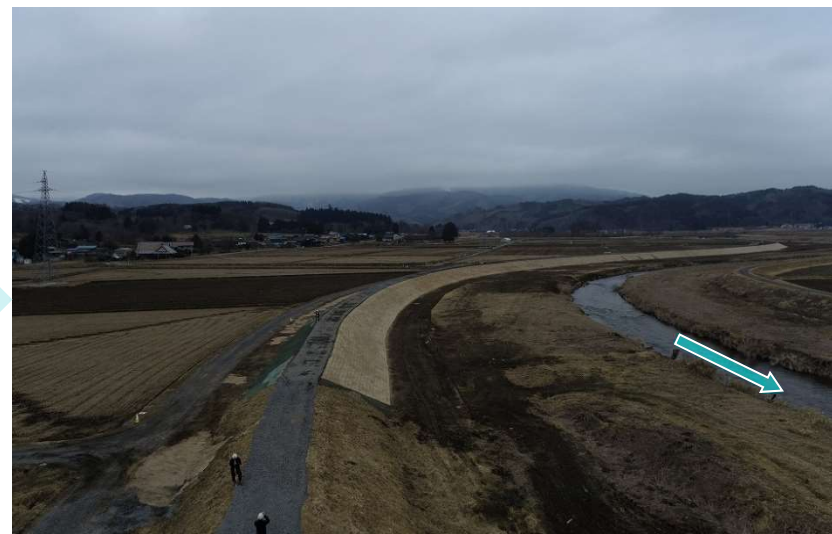
⑦ 【R5.3撮影】 施工中 10K450右岸上流
