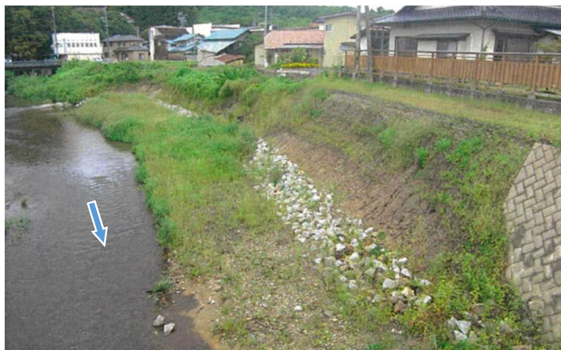
③【着手前】白山橋上流（R2.9撮影）
