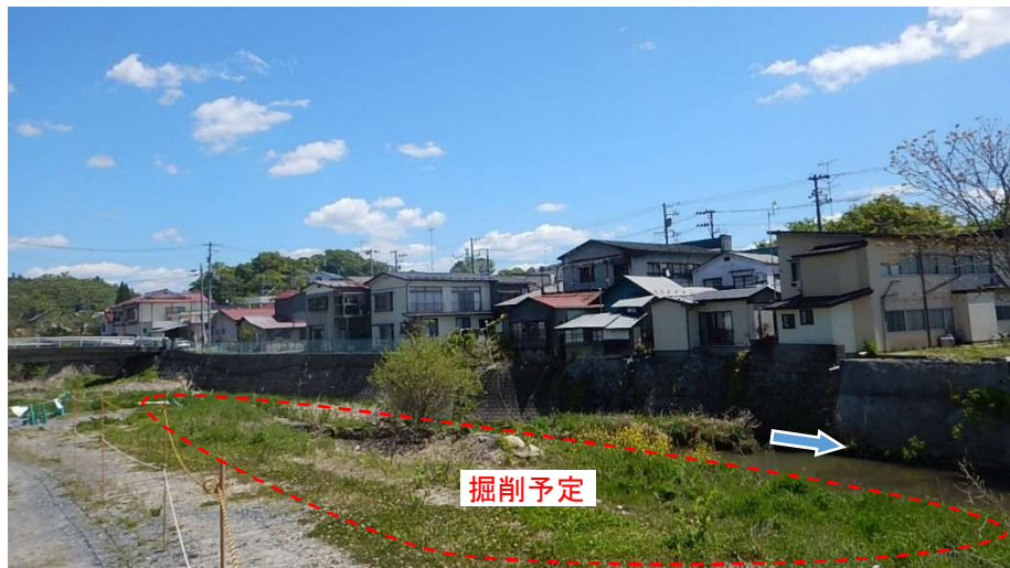
⑥【未着手】めおと橋上流 (R5.5.11撮影)
