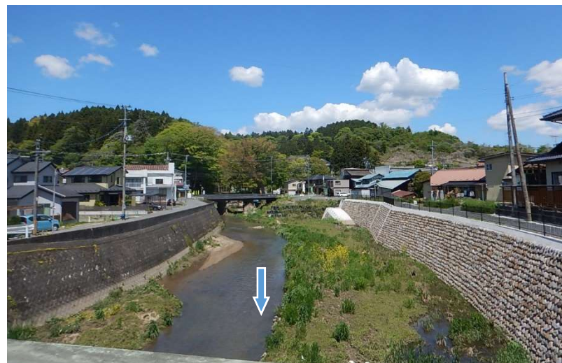
③【完了後】白山橋上流（R5.5.10撮影）
