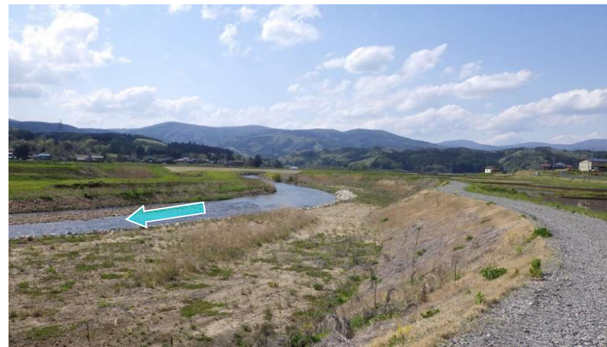
⑥ 【R5.5撮影】 施工中 10K200左岸上流
