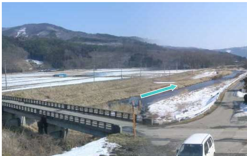
③【H21.3撮影】着手前 安居台橋下流
