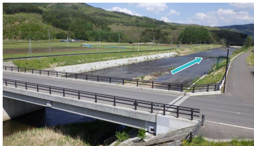
③【R5.5撮影】完了後 安居台橋下流
