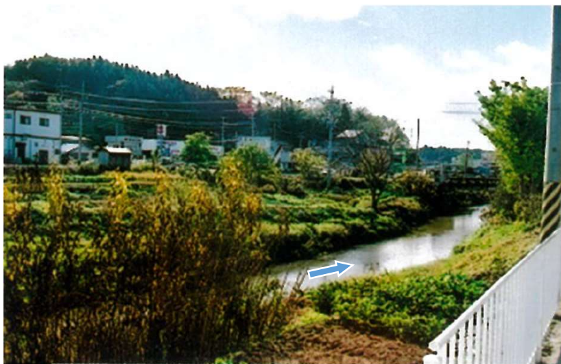
②【着手前】摩王橋下流（撮影時期不明）
