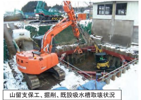
山留支保工、掘削、既設吸水槽取壊状況
