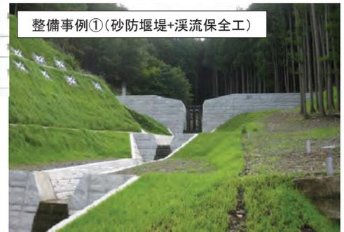
整備事例①(砂防堰堤+溪流保全工)
