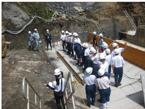
工事現場内の見学
