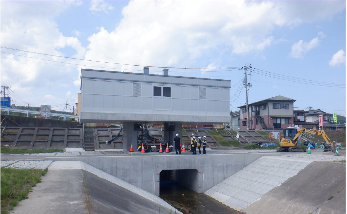
二級河川沢川 新中の橋樋門 全景
