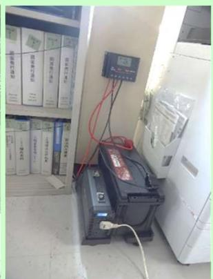
外壁に設置したソーラーパネルで発電した電力をバッテリーに蓄え、インバータを介して得られたAC100Vをオフィス機器に使用
