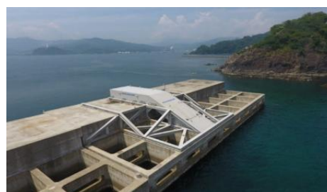
インテリジェント吸波式 波力発電システム実証機
