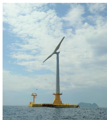
北九州市沖バージ型浮体風車 「ひびき」
