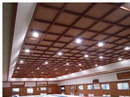
山田町立武徳殿照明のLED化（令和5年度）
