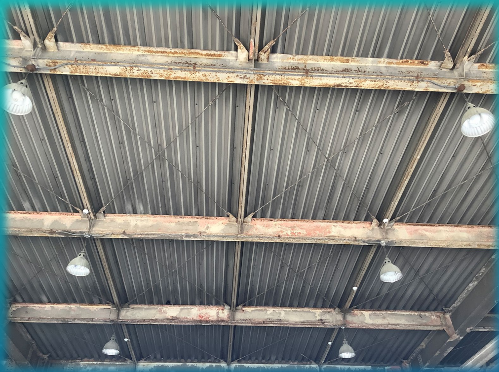
工場内 水銀灯
